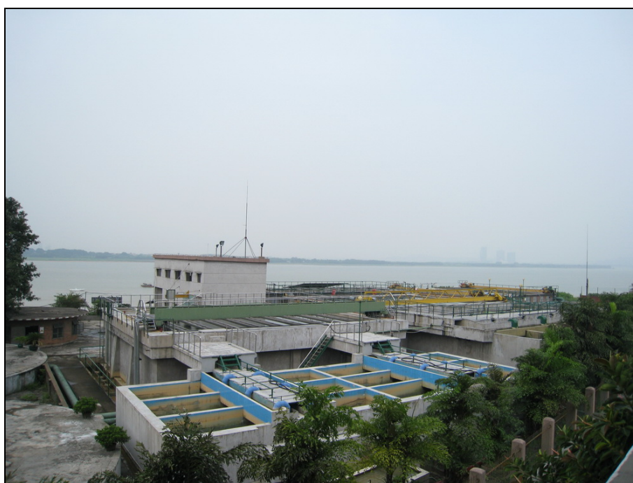
裕泉水厂全貌
